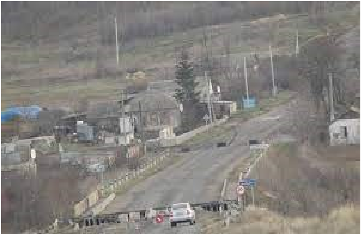
Фото 4. Зруйнований міст між селами Гранітне та Старомар'ївка через річку Кальміус, 28 серпня 2014 рік. [3.1]
