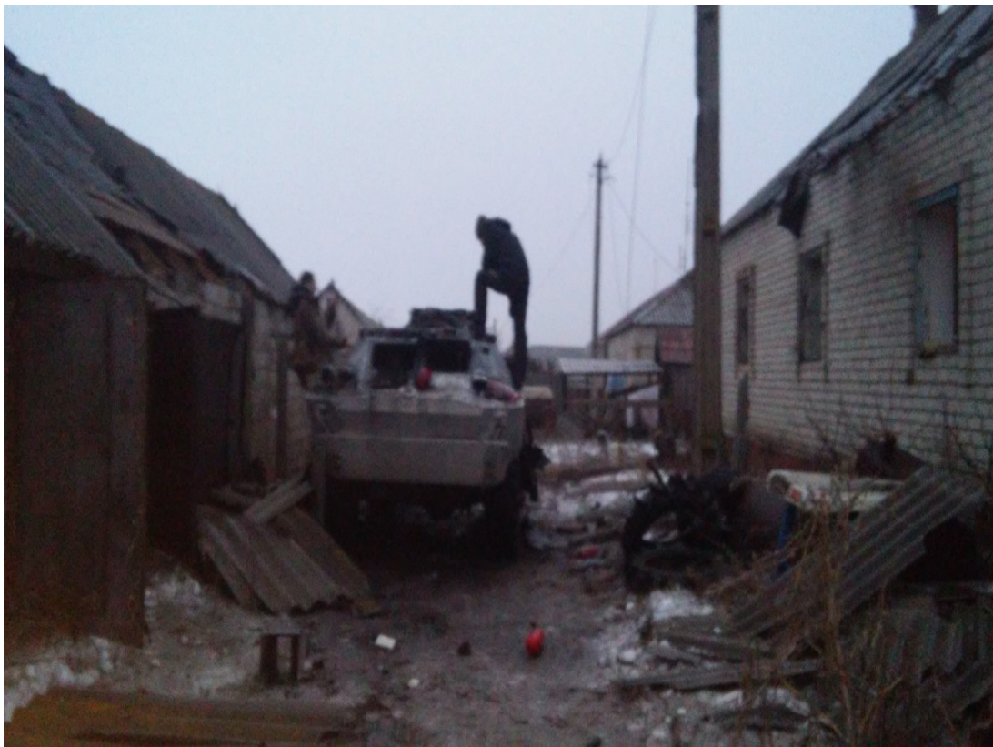
Фото 8. Будинок після обстрілу село Старогнатівка, січень 2015 рік.[2, с. 101]
